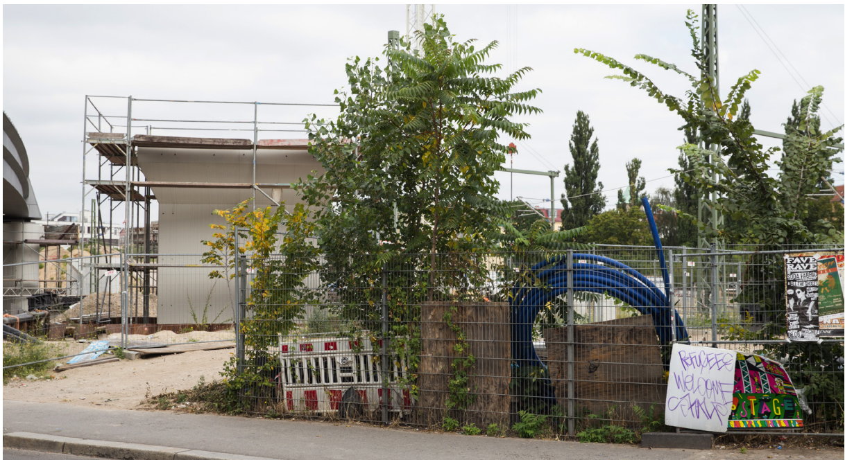
Abb. 2 Großbaustelle Bahnhof Ostkreuz, Weiterbau von Gleis- anlagen auf Brachland (Foto: Anna Blattner)
